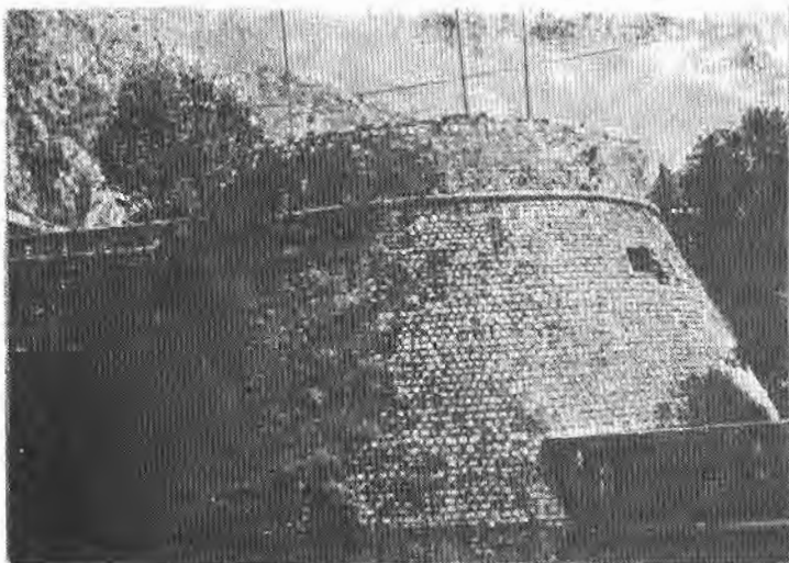
Sl. 4. Dio Citadele tretirane herbicidima (desno) i obrasle biljkama (kontrolna površina) (lijevo)
