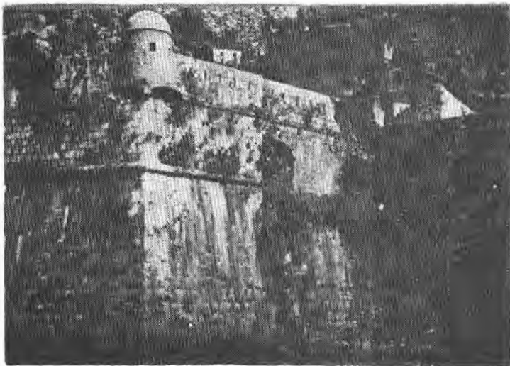
Sl. 3. Izgled površine zidina obraslih raznim vrstama biljaka (dominiraju vrste: Campanula pyramidalis , Portenschlagia ramosissima i Rubus ulmifolius )
